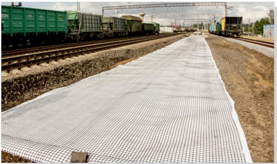
Георешетки СТАБАРМ ЖД-П предназначены для применения в качестве армирующего и разделяющего слоя в конструкциях насыпей земляного полотна и откосах железнодорожных сооружений, а также для усиления подбалластного слоя подрельсового основания железнодорожного пути, а также для применения в конструкциях, воспринимающих высокие динамические или статические нагрузки.
